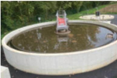
amenées par un racleur à lame de fond dans un puisard à boues d'où elles sont soit recyclées vers le bassin d'aération pour l'activation, soit extraites vers la filière de traitement des boues.
