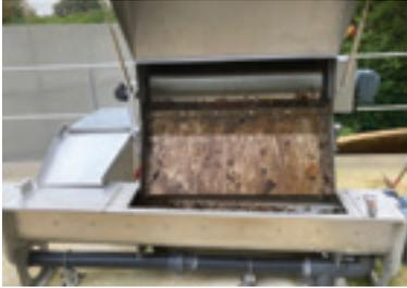
Les eaux usées passent alors à travers un dégrilleur, une sorte de **tamis**. Celui-ci permet d'extraire les feuilles et débris qui sont dirigés dans un sac sous le tamis et vidé par un agent technique.
