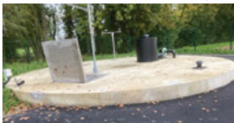
Il est alimenté par le canal de répartition lorsque le débit d'arrivée dans le tamis est supérieur à 40 m<sup>3</sup>/h. Afin de limiter les risques de fermentation, il est équipé d'un système d'homogénéisation, d'aération et de lavage du radier.
