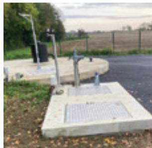
**Le bassin tampon** est un ouvrage béton armé neuf de volume utile de 104 m<sup>3</sup>. Son rôle est de stocker les eaux excédentaires lors des pointes de débit.
