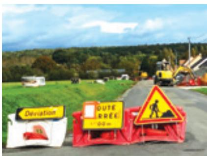
Les travaux de l'aménagement de la rue de la Croix des Buis sont essentiellement dans un premier temps, l'enfouissement des réseaux, la réalisation du pluvial tout au long de la rue du côté droit en remontant vers la maison de santé, la réalisation de trottoirs de chaque côté de la rue avec une piste cyclable du côté gauche en remontant vers la maison de santé et l'aménagement de parkings du côté droit. Dans un deuxième temps les enrobés seront réalisés.
